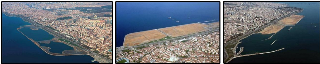
Foto 2: Maltepe Sahil Parkı Oluşturulurken Yapılan Dolgu Çalışmaları
