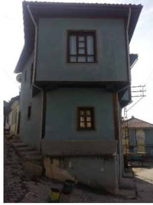
Şekil 3.2. Mevcut topografyaya bağlı iki girişli yapı örneği
