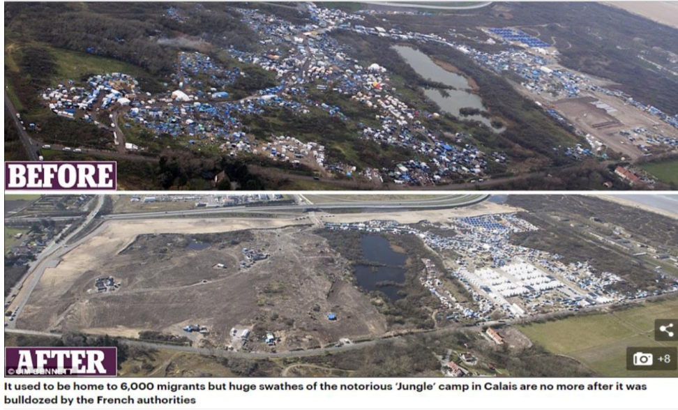
Resim 15: Calais Kampı yıkım öncesi ve sonrası (Bennett, 2016)
